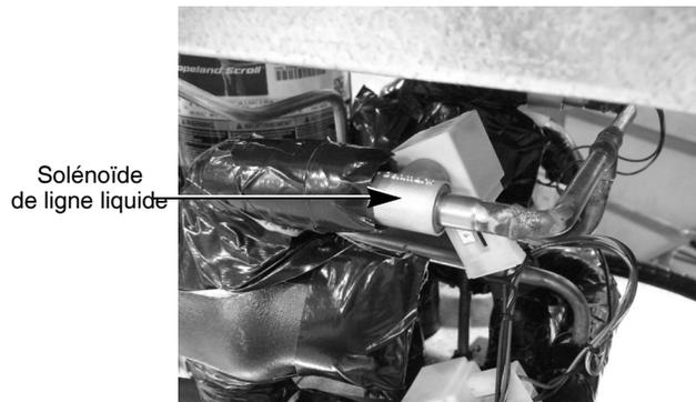
Figure 49. Solénoïde de ligne liquide (1 par barillet)
